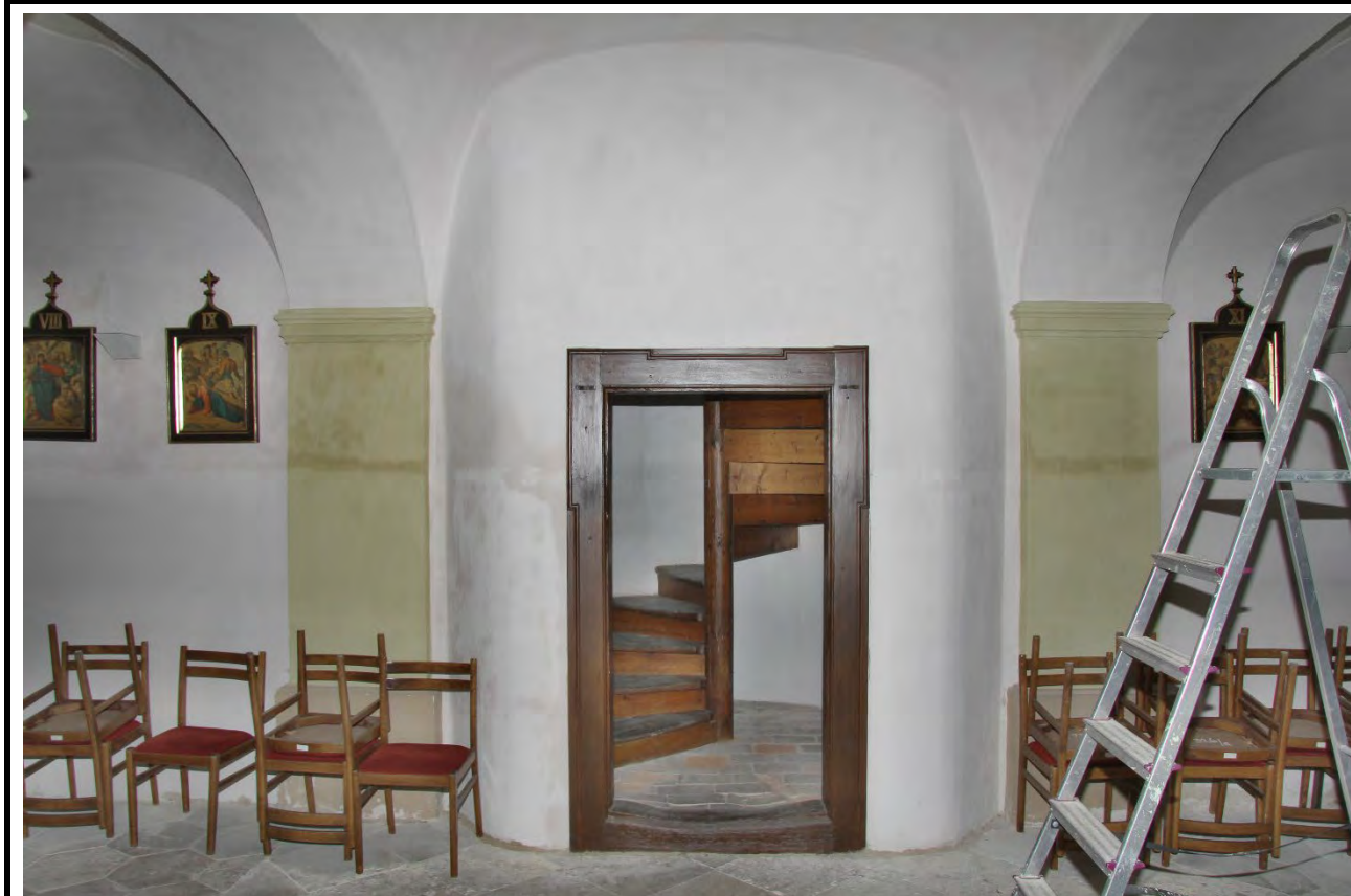
Čelní pohled od východu na západní vstup na točité schodiště směřující na kruchtu. Foto: Jaroslav Skopec, 2019.
