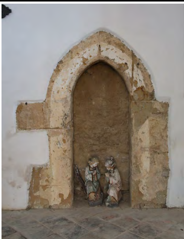
Čelní pohled od východu na zalděný portál sakristie směřující na točité schodiště. Foto: Kateřina Neumannová, 2015.
