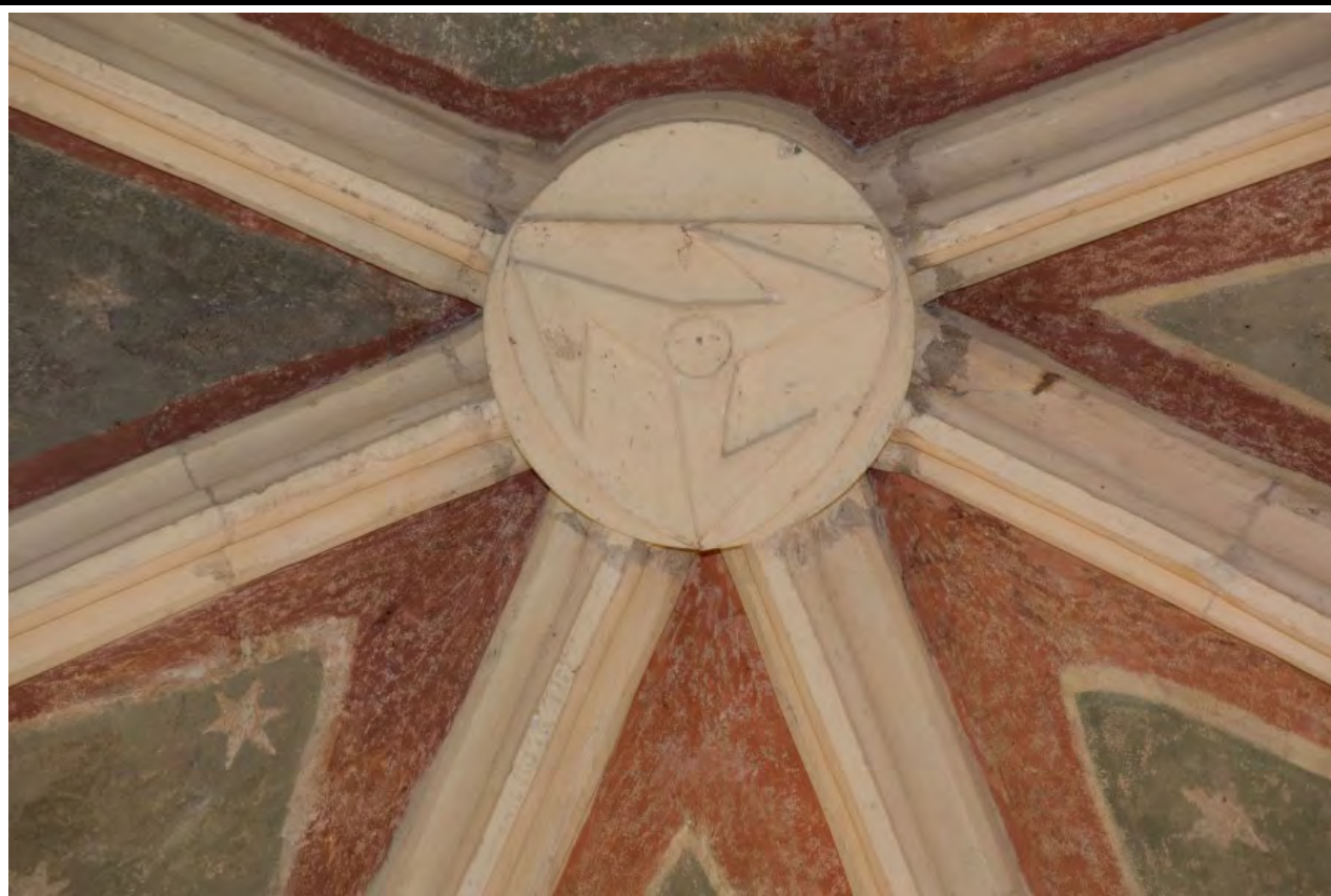
Detail závěrového svorníku klenby presbytáře. Foto: Kateřina Neumannová, 2015.
