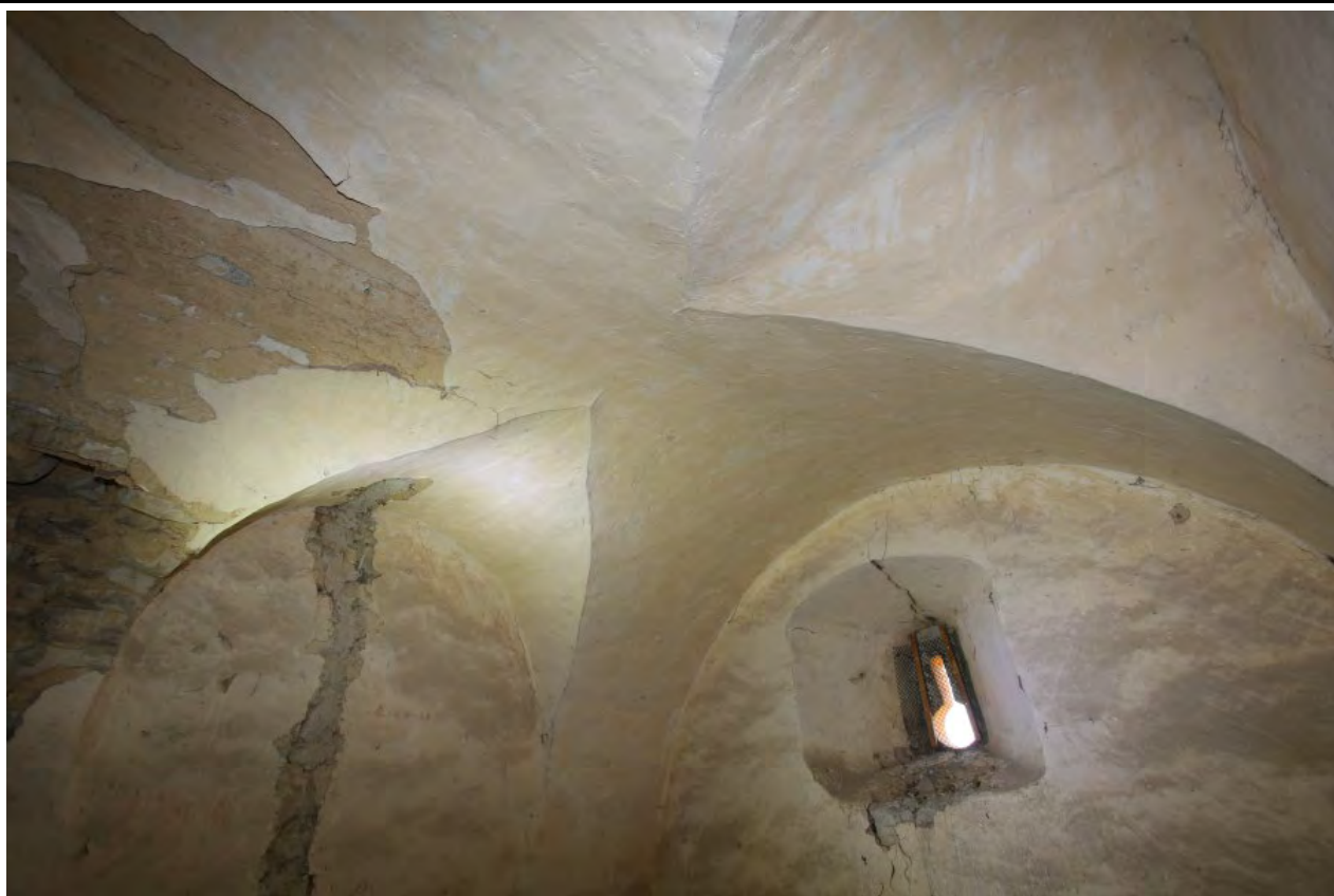
Interiér prvního patra věže v pohledu od jihozápadu. Foto: Kateřina Neumannová, 2015.
