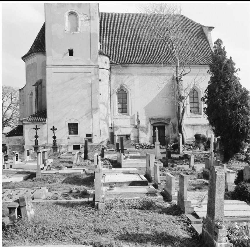
Celkový pohled od jihu. Foto: 1988, sbírka negativů NPÚ ÚOP v Ústí n. L., sign. 96424.
