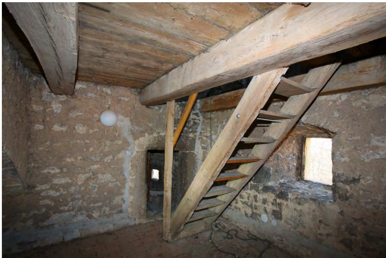
Interiér druhého patra věže v pohledu od jihovýchodu ke vstupu na točité schodiště. Foto: Kateřina Neumannová, 2015.
