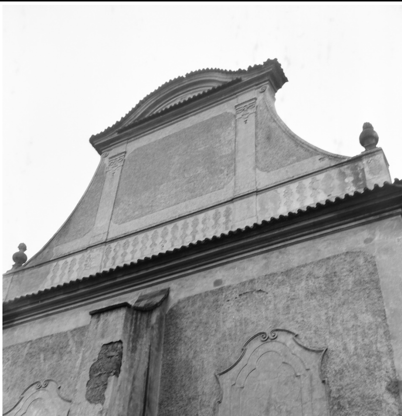
Západní štít lodi v pohledu od jihozápadu. Foto: 1966, sbírka negativů NPÚ ÚOP v Ústí n. L., sign. 24406.
