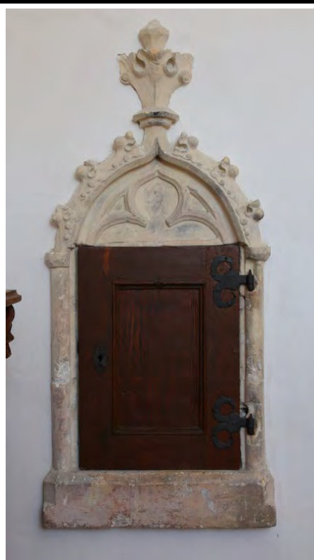
Čelní pohled od severu na sanktuář osazený v jižní zdi sakristie. Foto: Kateřina Neumannová, 2015.
