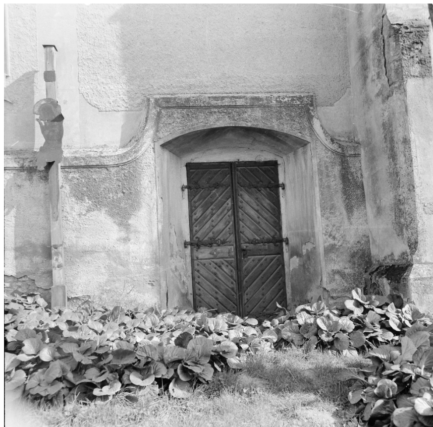
Čelní pohled na severní vstup lodi. Foto: 1988, sbírka negativů NPÚ ÚOP v Ústí n. L., sign. 96425.
