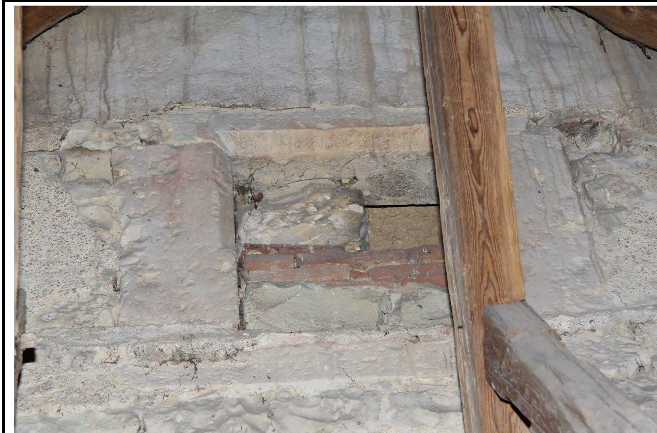
Zazděný okenní otvor třetího patra věže v pohledu od jihu z prostoru krovu presbytáře. Foto: Jaroslav Skopec, 2019.
