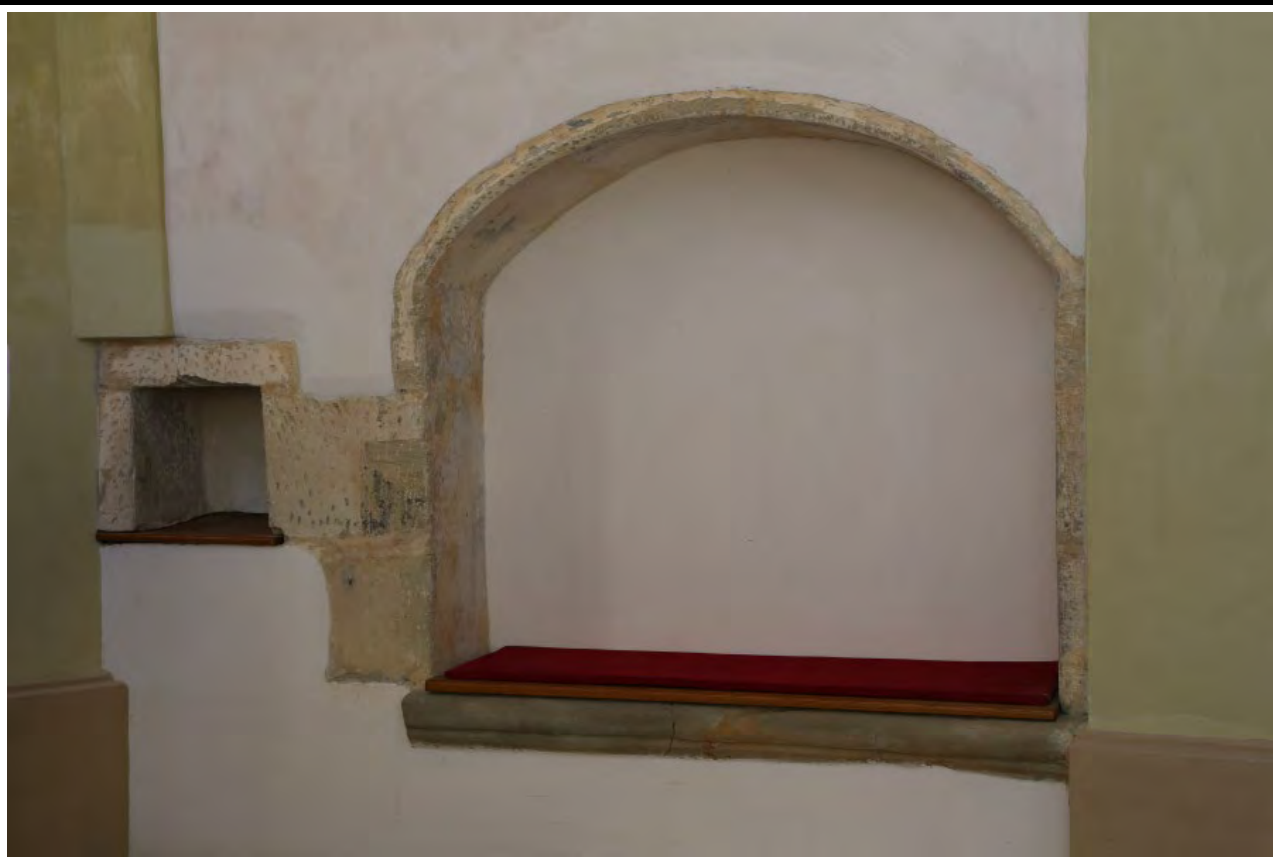
Čelní pohled od severu na sedile a odkládací výklenek v jižní zdi presbytáře. Foto: Kateřina Neumannová, 2015.
