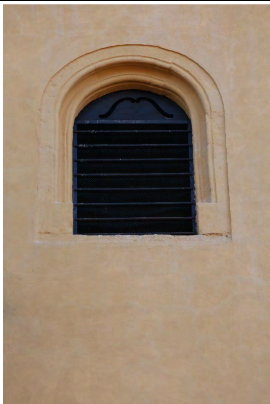
Východní zvukový otvor pozdně gotického zvonového patra věže. Foto: Kateřina Neumannová, 2015.
